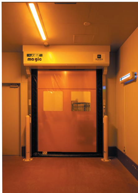
波長500nm(可視光線)における防虫シートバグバスター全閉状況
