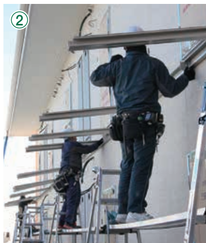
② 妻梁、根太材(打付材側)の取付け
