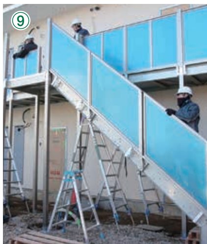
⑨ アルミ手すり(廊下部、階段部)の取付け ササラカバーの取付け
