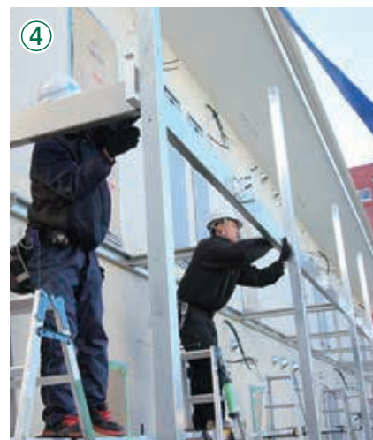
④ 桁材、根太材(桁材側)の取付け
