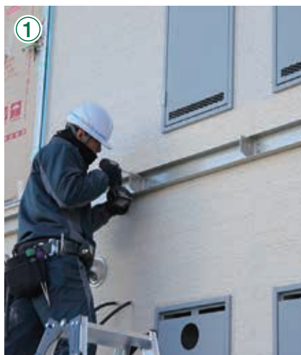
① 打付材の取付け
