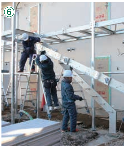
⑥ ササラ桁、ターンバックルの取付け
