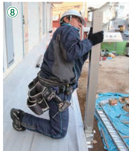
柱力バー(上部、下部)の取付け
