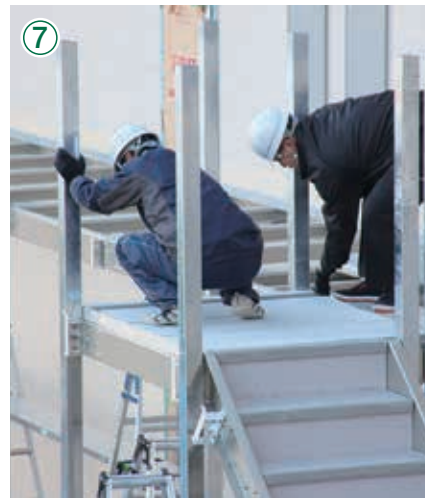
階段踏板、廊下部床材の取付け
