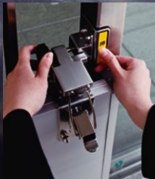
③ 止水板を固定し
