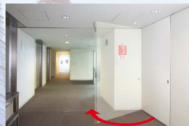
防災信号によりリリースのフックが外れ、戸袋から90° 閉鎖します。
