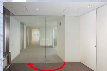
折れ戸が 180° 閉鎖して防火区画を形成します。
