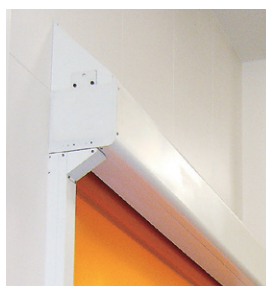
▲施工例／ 本体ボックス用傾斜カバー
