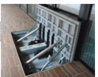
電動・手動起伏式止水板
