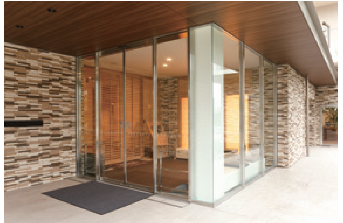
建物の入り口にステンレス自動ドアを設置。玄関は段差がなく自動ドアのバリアフリーで、車いすをご利用の方もスムーズに移動できる。
